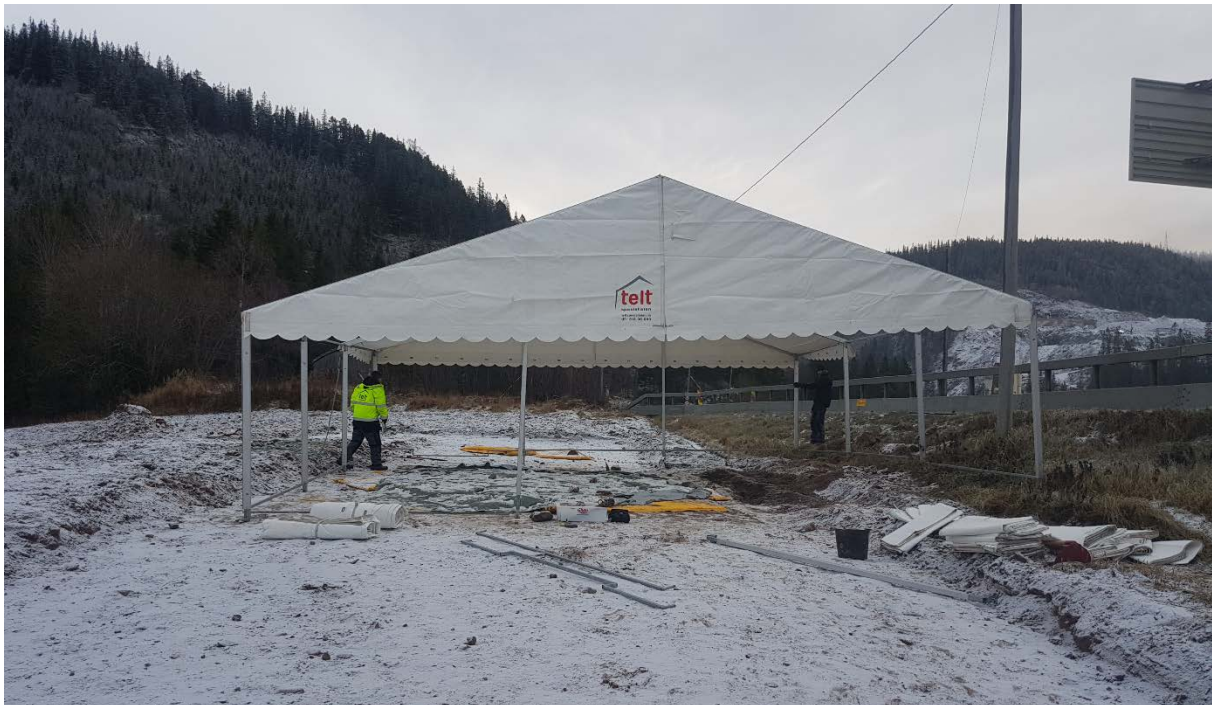
Figur 9. Teltet under rigging. Bildet er tatt mot SØ. Da_62221_044. Foto: Eivind Krag, NTNU Vitenskapsmuseet.
