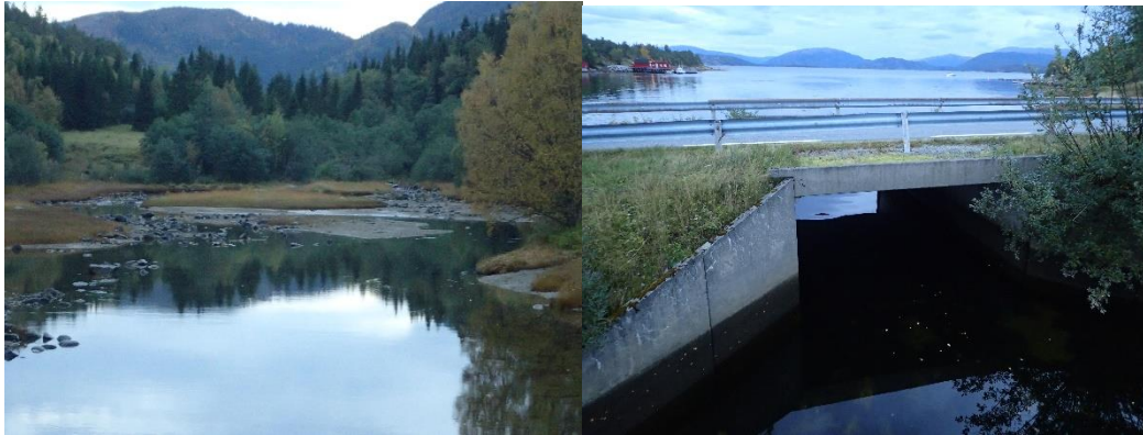
Bilde: Nedre deler av Fiskeroselva (t.v.) og betongbru ved utløp i sjø (t.h.).
