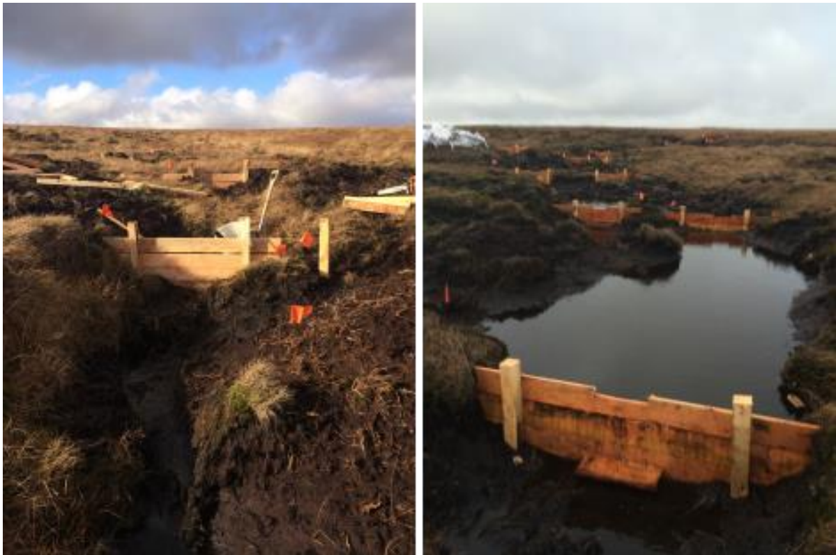
Figur 29. Eksempler på tredemninger. Foto: DTMS Group for Moors for the Future ( http://www.dtmsgroup.co.uk/moors-for-the-future ).
