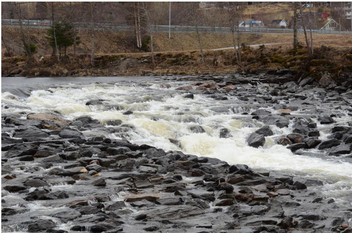
D: Øvre del av terskelen i Garbergelva.
