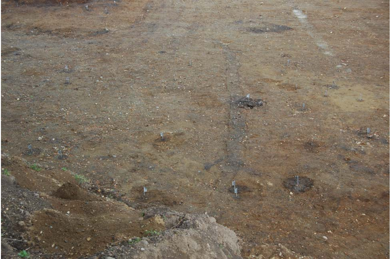
Figur 9. Vegg-grøft Hus II
