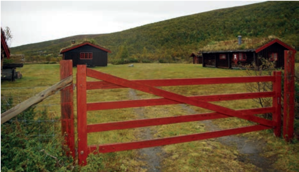
5.36 Storrøsvollvollen rett utafor den rødmalte grinda sett i nordlig retning. Seterbua er i god stand og var det også ved første gangs restaurering på 1980-tallet. Den har innskrift «1801». Bua er restaurert med ny kledning på gavlveggene og ved inngangspartiet, nytt tak med nye vindskier og torvhald. SEFRAK nr. 230. Foto: Aud M. Tretvik.
