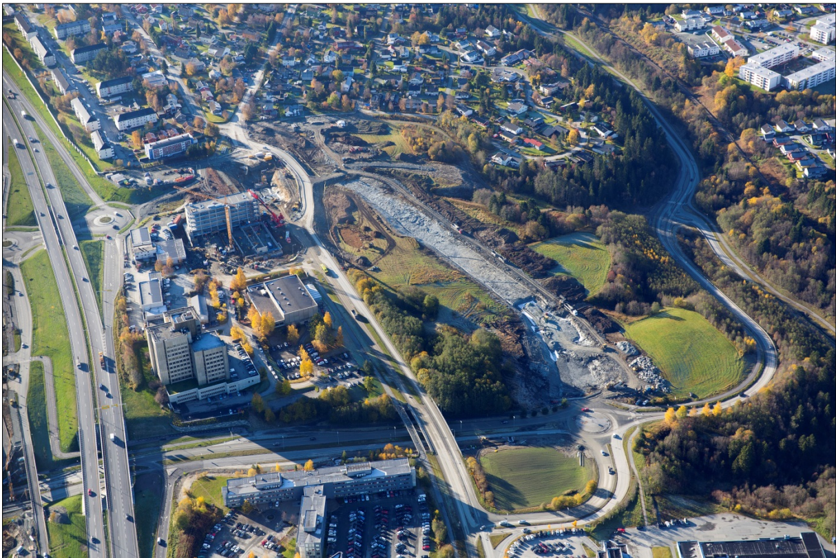
Figur 2: Da57690_125 Flyfoto over undersøkelsesområdet og anleggsvirksomheten rundt. Det undersøkte området ligger midt i bildet. Bildet er tatt mot sør. Foto: Erling Skjervold, Statens vegvesen
