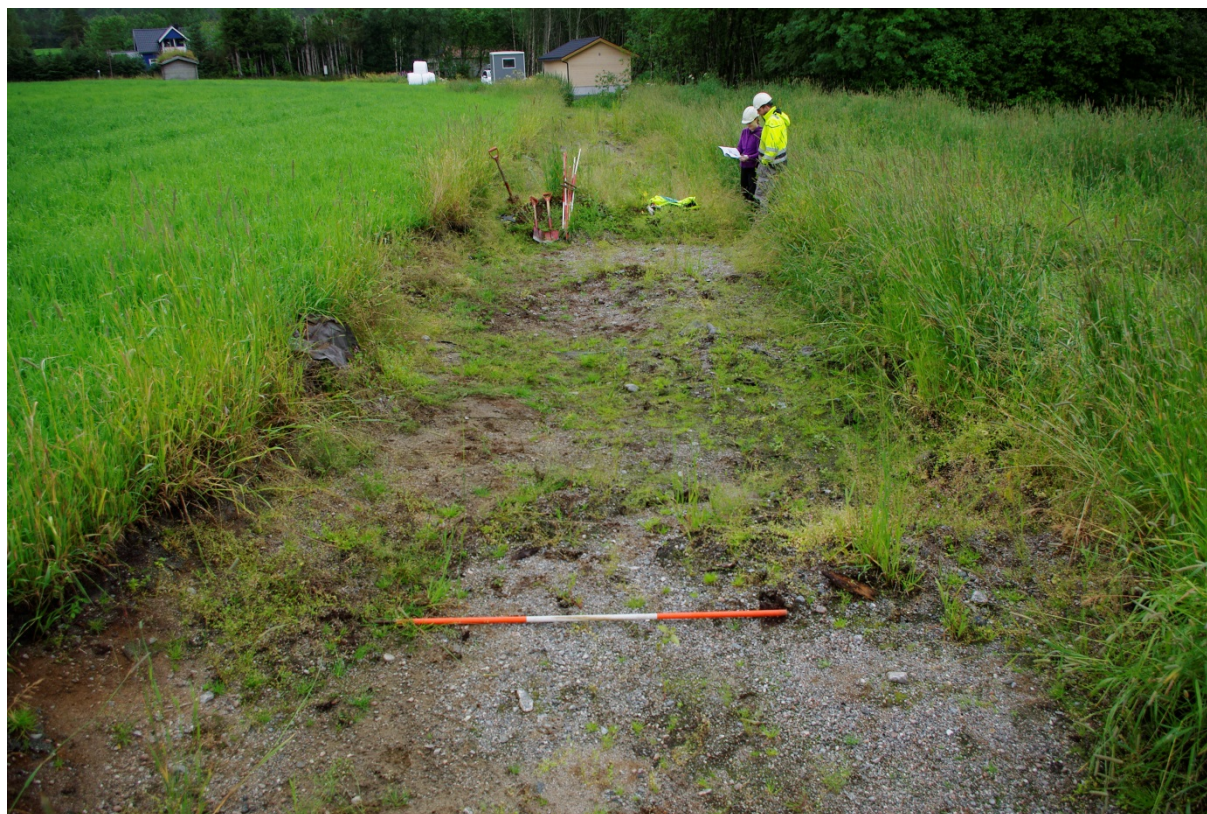
Figur 7: Kabelgrøften før undersøkelsen tok til (Da57704_02). Foto: Magnar Mojaren Gran, NTNU Vitenskapsmuseet
