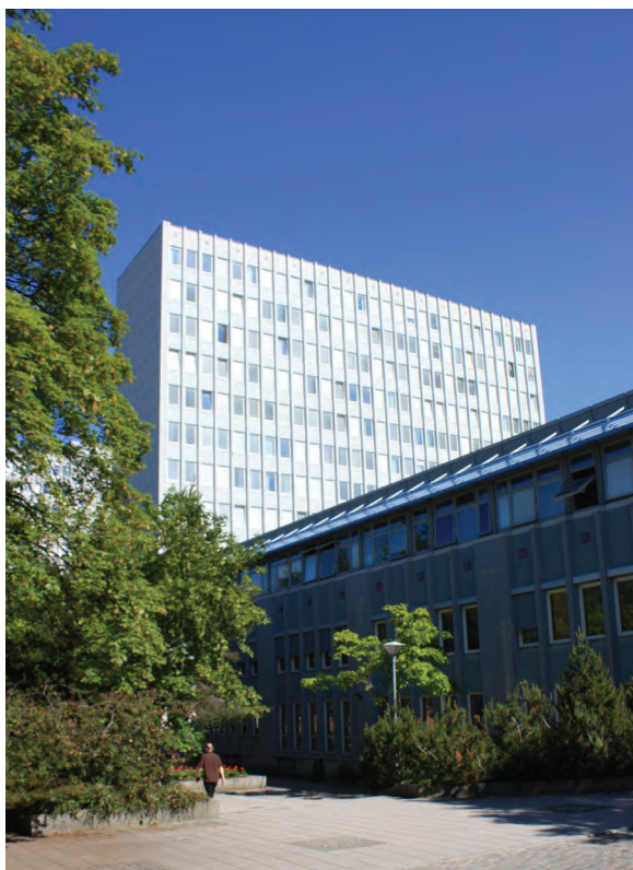
Sentralbygg 1 og Søndre lavblokk sett mot nord-øst.
