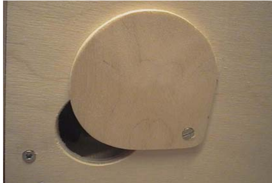
Figur 162 Hull for å dra ut nettkabelen.
