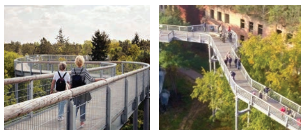
Eksempelbilder for utforming av bru (9 og 10)
