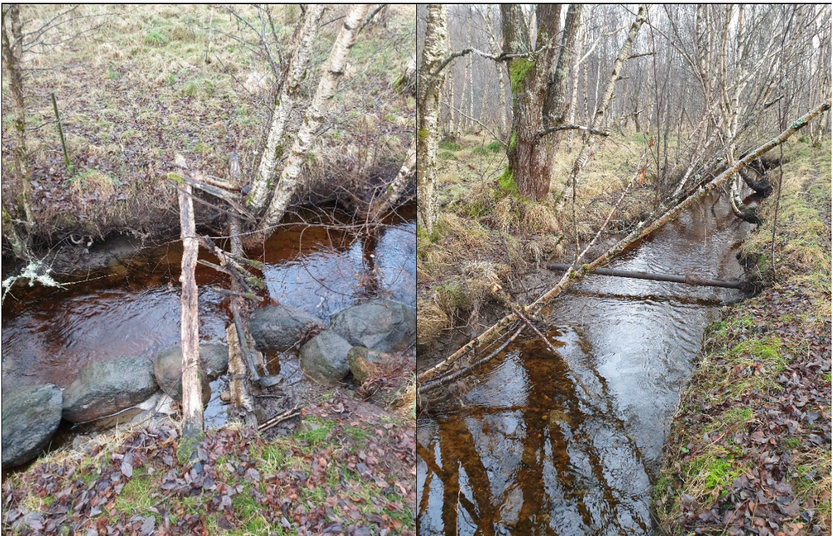
Bilde: Den gamle trebrua (t.v.) og et jernrør som går tvers over elva ca. 30 m nedstrøms trebrua (t.h.). Bildene er tatt på lav vannføring i desember.
