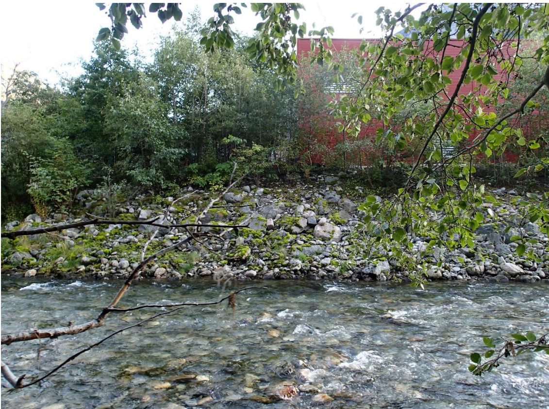
Figur V6. Stasjon 1 Grøa (høyre side) begrenses nedstrøms ved østre vegg av nærliggende næringsbygg (Sundalspotet AS).
