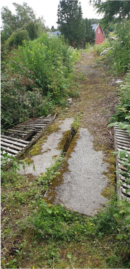
Figur 3. Den øverste delen av stien langs Midtsandbekken, dvs. den delen av stien som går fra bekketrysningen og videre på bekkens vestsida og opp til smia, er anlagt etter 1947. Den leder turstien opp mot vestsida av gården i stedet for inn på tunet.
