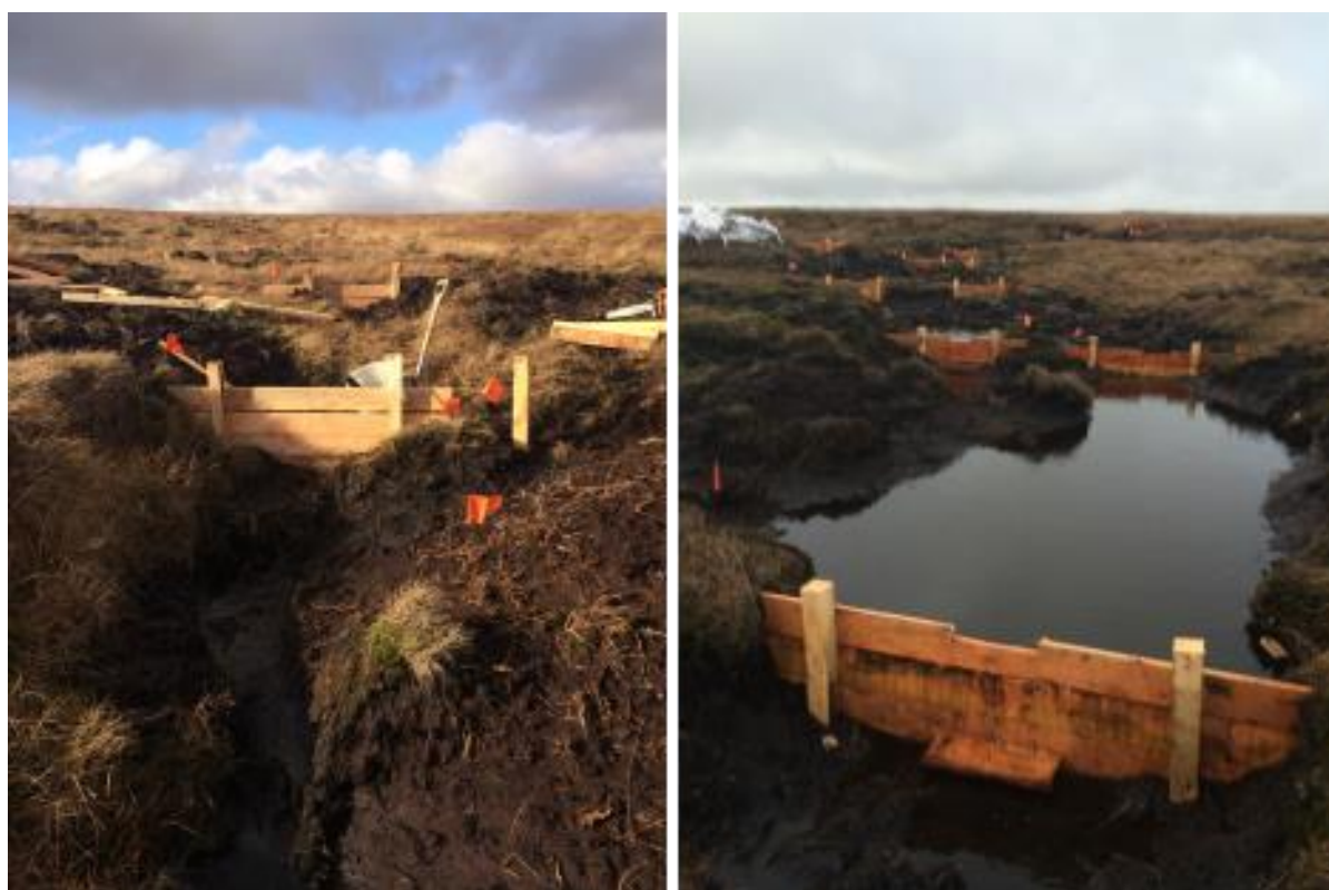
Figur 19. Eksempler på tredemninger. Foto: DTMS Group for Moors for the Future ( http://www.dtmsgroup.co.uk/moors-for-the-future )
