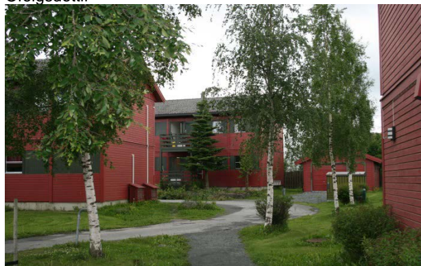
Eksempel på bygninger bygd for å være sentralisert mottak i 1990 i en by i midtnorge. Mottaket består av seks bygninger, alle laget av brakkemoduler. Foto: Eli Støa
