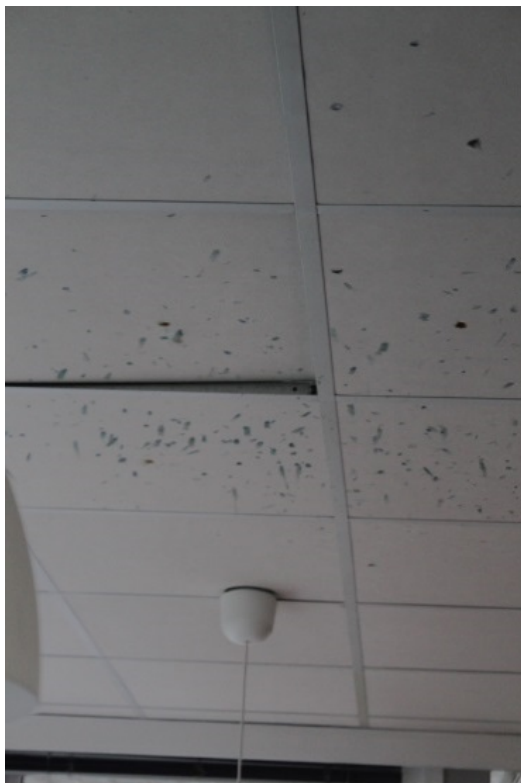
Til venstre: Eksempel på himling som ødelegges, i aktivitetsrom over biljardbord. Foto: SINTEF Byggforsk
