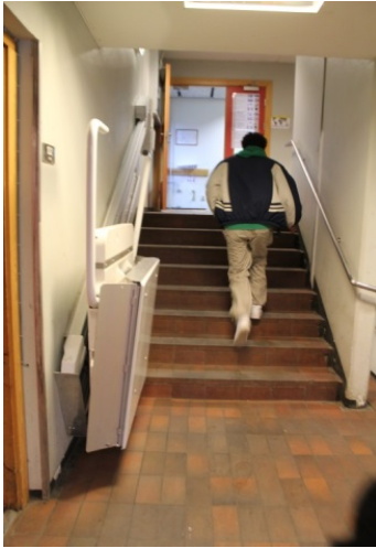
Til venstre: Eksempel på trappeheis mellom halvplan. Dette er en løsning som kan aksepteres ved tilrettelegging av eldre bygninger. Foto: SINTEF Byggforsk
